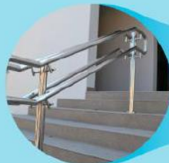
Instalação de corrimão
