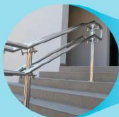
Instalação de corrimão
